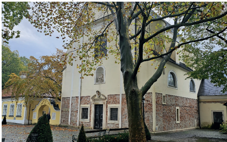
Wir haben mit der Renovierung unserer Ferialkirche in Frauenhofen begonnen
